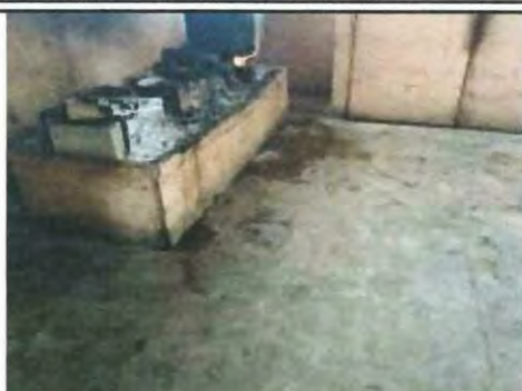
Foto 1: Sustitución de Polleton por estufa de leña de 2.5 mt. de largo por 1 mt. de ancho con 3 homillas mas campana y chimenea.
