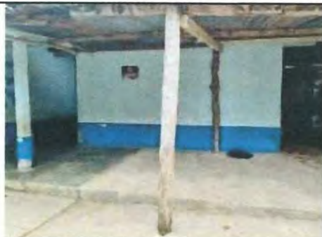
Foto 10: Sustitucion de pintura interior y exterior de la cocina.
