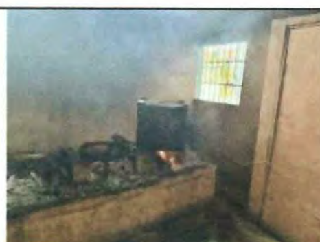
Foto 4: Elaboracion e instalación de ventana
