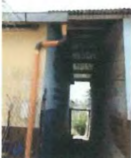
Foto 11: Elaboracion e instalacion de 2 puertas en el pasillo.
