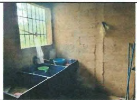
Foto 5: Elaboracion e instalación de ventana
