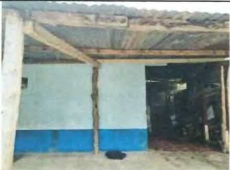
Foto 9: Reparacion de techo y sustitucion de laminas para corredor de cocina.
