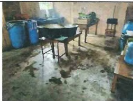
Foto 8: Sustitucion de piso liso por piso ceramico
